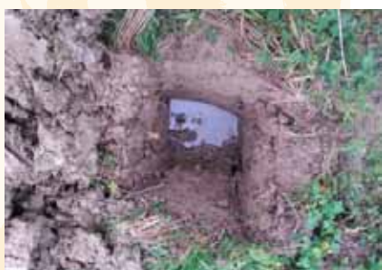
Présence d'eau à 20 cm de profondeur
