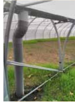
Gouttière collectant l'eau de pluie d'un bitunnel
