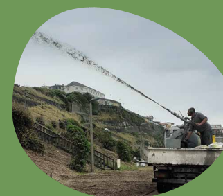
Technique de semis par hydroseeding Côte des Basques, Biarritz (64)
