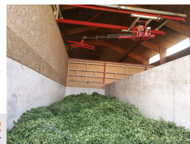
CHARGEMENT DU SÉCHOIR Servon-Melzicourt, juillet 2017
