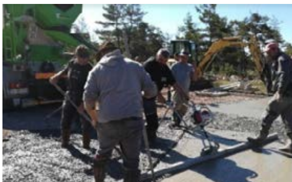
Le chantier participatif du bâtiment de stockage des grains.
