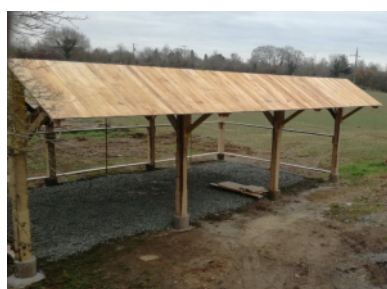
Toiture en bardeaux et bâtiment de stockage en cours de réalisation, à partir de poutres auto-produites
